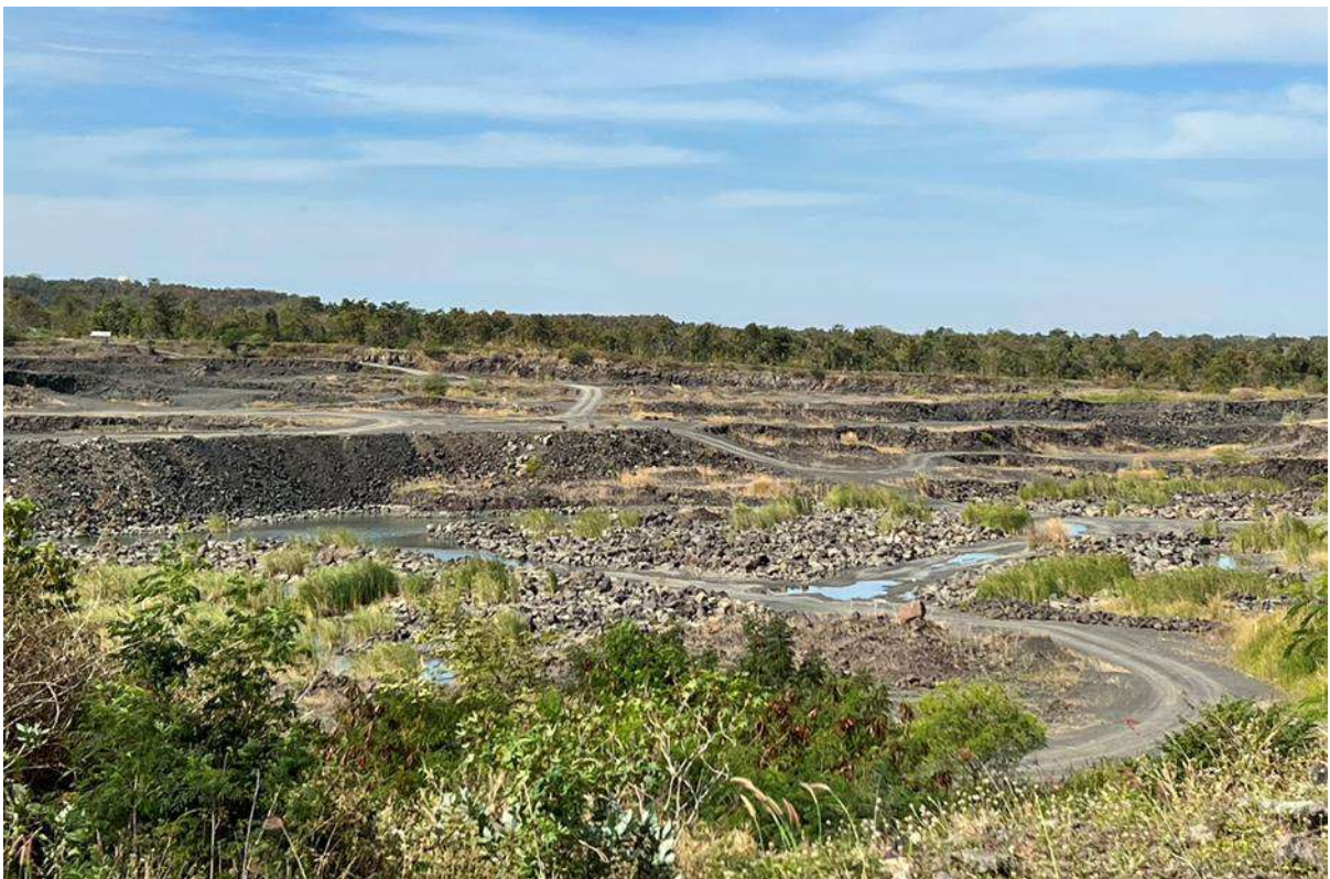
รูปที่ 5 หน้าเหมืองแบบขั้นบันได (Benching Method) และการปรับสภาพฟื้นฟูบริเวณหน้าเหมือง
